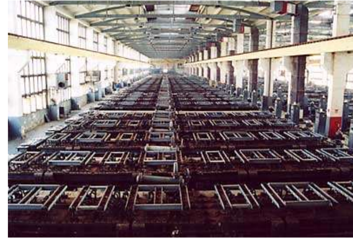
Hala elektrolizerów w dawnych zakładach Dwory S.A.
