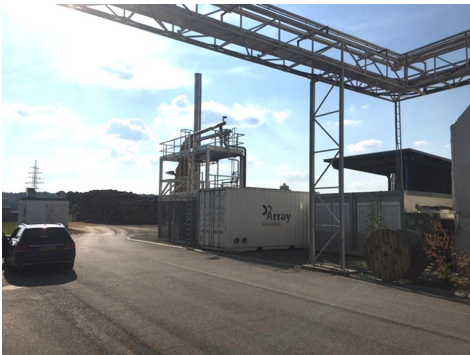
Fot. Instalacja pilotowa w Güssing (Austria)
