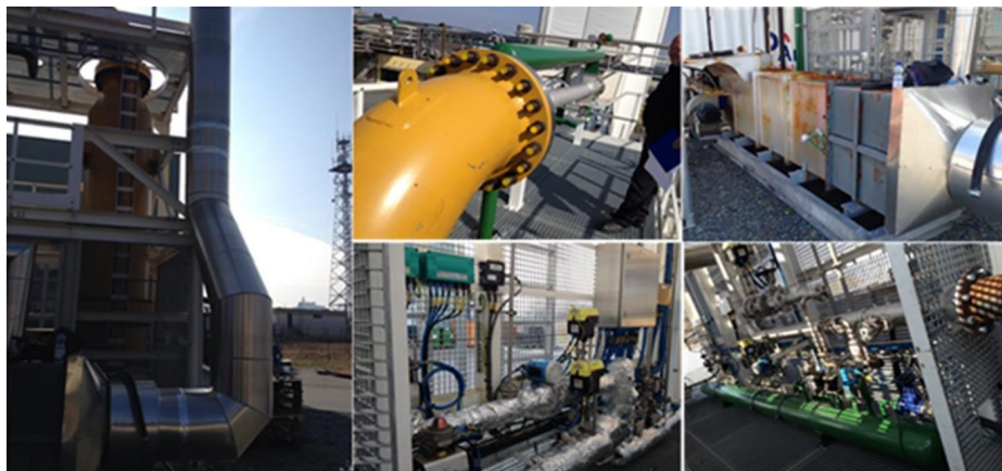
Fot. Instalacja pilotowa w Güssing (Austria)
