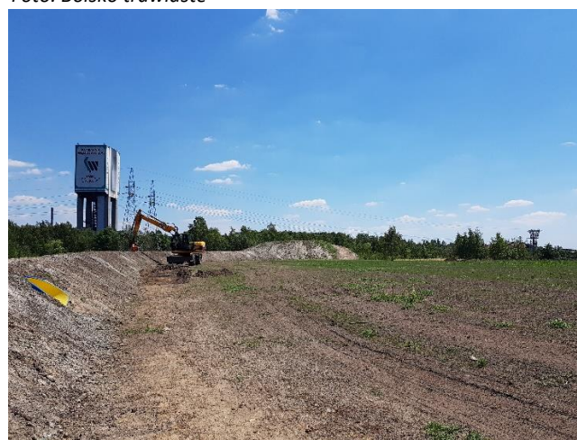
Foto. Ostatni etap robót ziemnych
