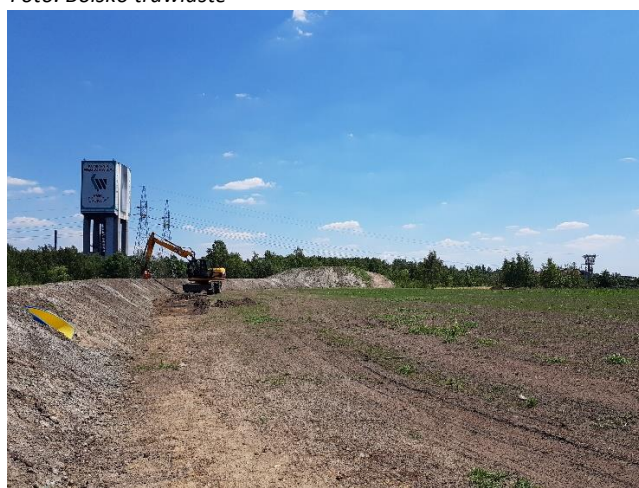
Foto. Ostatni etap robót ziemnych
