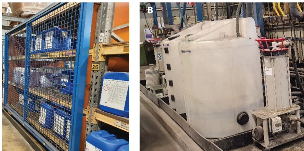
Fot. 2 a,b. Standard dobrej praktyki w galwanizerni w zakresie przechowywania i obchodzenia się z chemikaliami. Zbiorniki o wysokiej odporności na chemikalia, substancje niebezpieczne przechowywane w zamkniętej przestrzeni, z dostępem tylko dla upoważnionych osób. Substancje chemiczne reagujące pomiędzy sobą przechowywane oddzielnie. Strefy magazynowe i linie technologiczne z zabezpieczeniami przed rozlaniem i uwalnieniem ewentualnych wycieków (szczelne podszkazy, baseny bezpieczeństwa).
