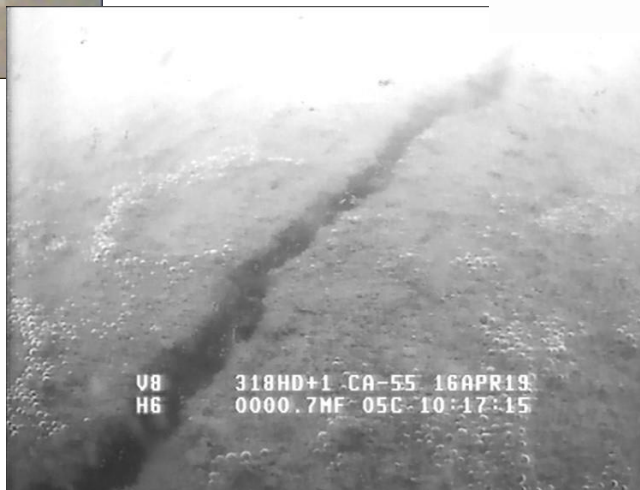
Chańcza - ekran zapory, strona lewa, przy przyczółku, WG
