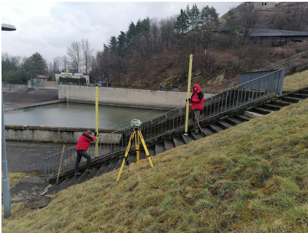
Pomiary niwelacji precyzyjnej zapory przy wykorzystaniu niwelatora Leica LS10
