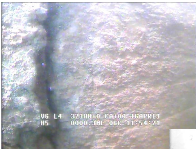
Ściana przyczółka, strona prawa, dylatacja, WG
